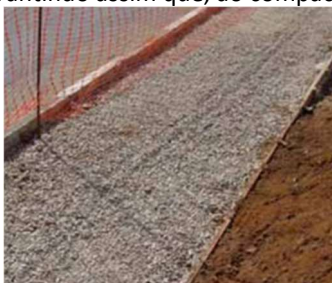
Figura 12 – Espalhamento da camada de Brita
