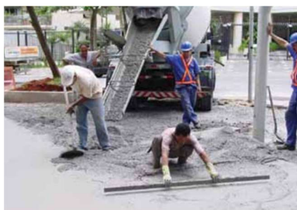
Figura 13 – Recebimento e espalhamento do concreto.
