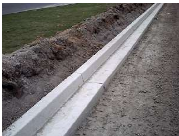
Figura 6 – Detalhe Guia e Sarjeta Conjugados Extrusados.
